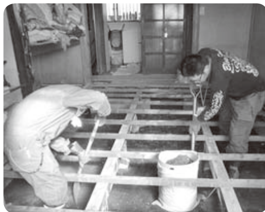
▲床板をはがし、梁だけとなった床下から泥をかき出します。
