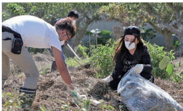
▲敷地に流れ着いた大量のわらは、水を含み片付けるのが大変でした。
